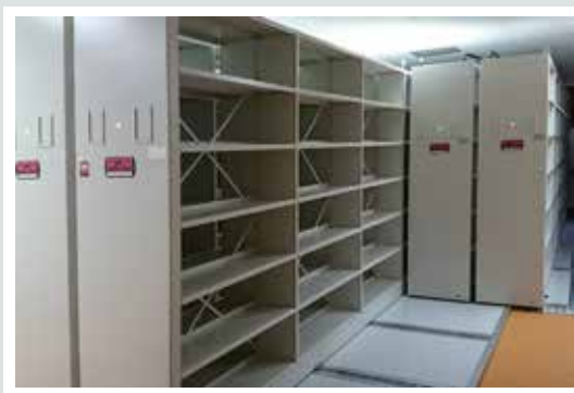
regały z napędem elektrycznym w archiwum
